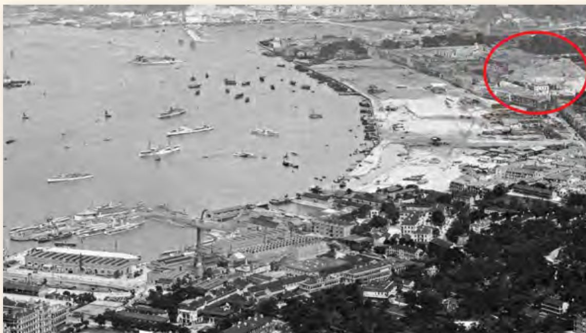
▲ 填海工程已近完成，大片新土地的右側為開採中的摩利臣山（紅圈所示），攝於約1920年代（圖片來源：香港大學圖書館特藏部）
